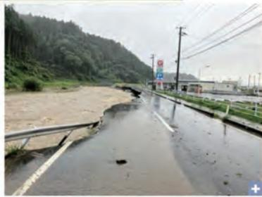
八幡川の水位上昇により陥没した国道398号=16日午前8時すぎ、宮城県南三陸町志津川駅前下 (原気仙沼土木事務所提供)
